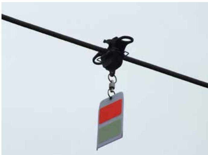
Obr. 6 a 7. Kolíziám vtákov s elektrickým vedením na rizikových úsekoch zabráňujú tzv. odkloňovacie prvky, ktoré majú za cieľ elektrické vedenia zviditeľniť.
